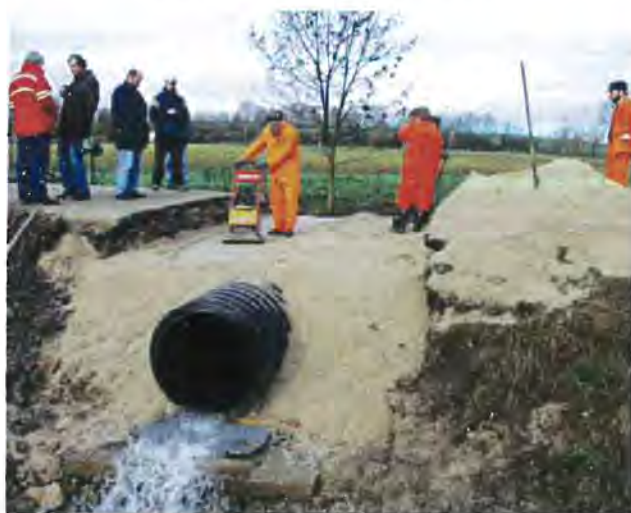
Figura 5. Compactarea materialului de rambleu deasupra conductei
