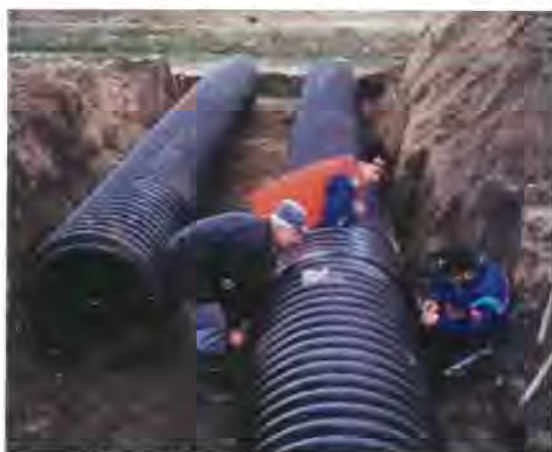
Figura 3. Instalarea conductei
